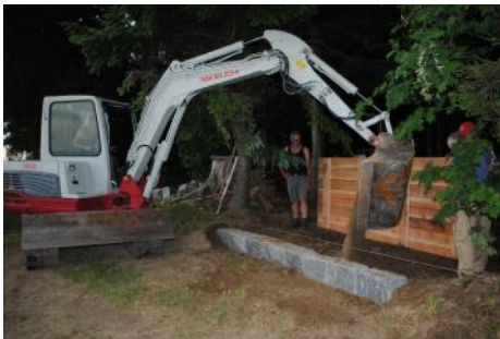
Hier ist viel Kraft im Einsatz!
