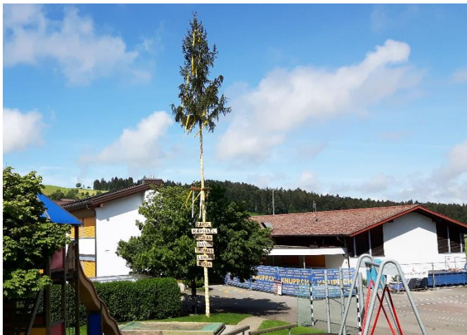
Der Maibaum 2020 und im Hintergrund die Baustelle für die Sanierung der WC-Anlage.
