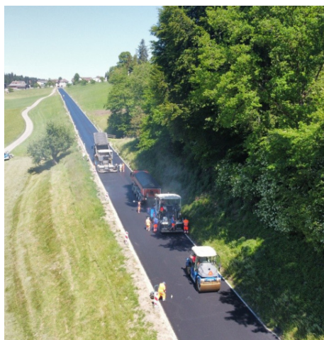
Zwei Einbaufertiger, fünf Walzen und sechs Lastwagen sowie rund 20 Personen waren im Einsatz, damit der Belag innerhalb eines Tages eingearbeitet werden konnte.
