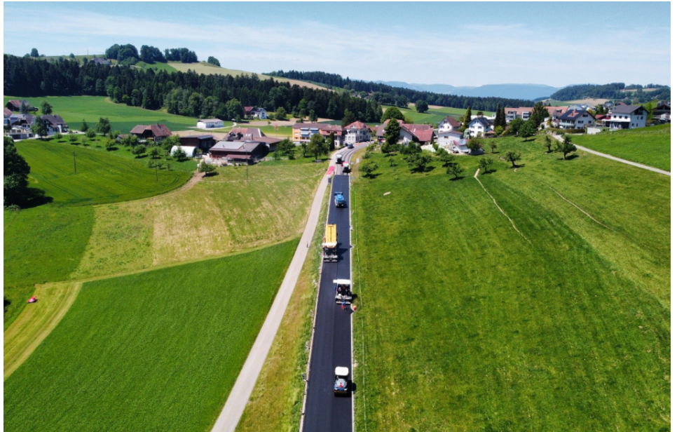
Am Samstag, 23. Mai, war die Kantonsstrasse Fischbach-Zell gesperrt, damit der Feinbelag eingebaut werden konnte.
