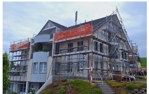
Die seit Mai laufenden Sanierungsarbeiten am Gemeindehaus werden bald abgeschlossen sein.
