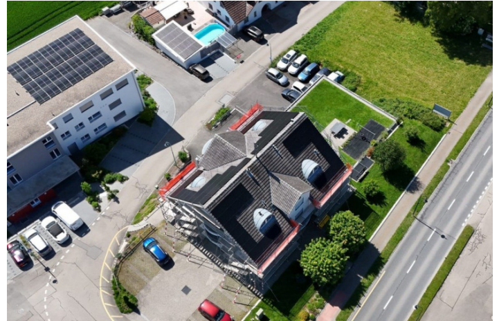
Ein Blick aus der Luft zeigt: Auf dem Gemeindehaus und vielen weiteren Dächern bringen Photovoltaikanlagen nachhaltigen Fortschritt in der Gemeinde.
