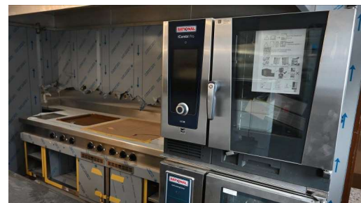
Der neue Herd und die beiden Combi-Steamer warten in der vorbereiteten Küche darauf, fertig angeschlossen und in Betrieb genommen zu werden.
