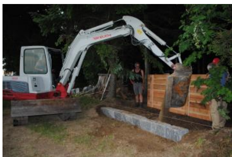
Hier ist viel Kraft im Einsatz!
