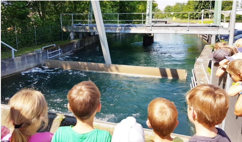
Gespannter Blick in den Reusskanal, der zum Wasserkraftwerk führt.
