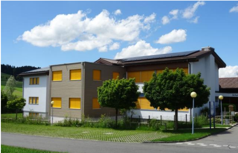
Längst hat man sich an das veränderte Aussehen der Schulanlage gewöhnt. Der Erweiterungsbau dient der Schule vortrefflich.
