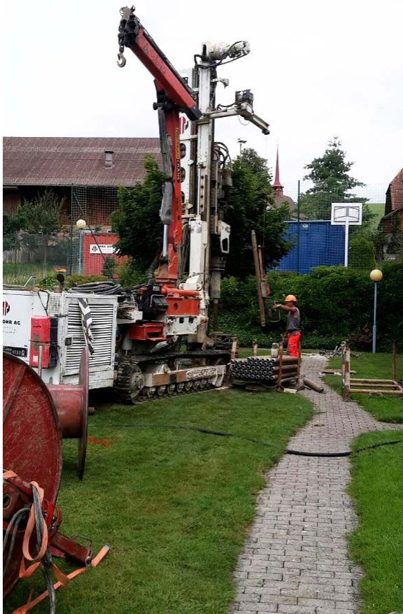
Sechs Bohrungen waren nötig. Gebohrt wurde jeweils 200 Meter tief. Der Unterboden bestand fast vollständig aus Sandstein.
