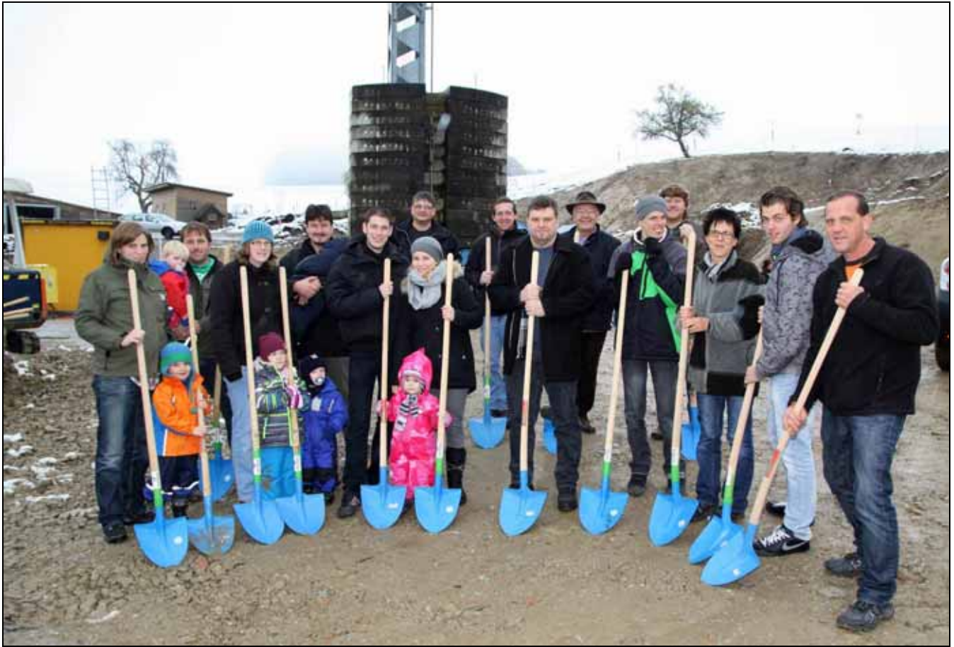
Die künftigen Bewohner beim Spatenstich. Im Hintergrund die Initianten Ivo Häfliger, Roland Häfliger, Werner Leuenberger (Vertreter Leuenberger Architekten AG Sursee) und Urs Kammermann.
